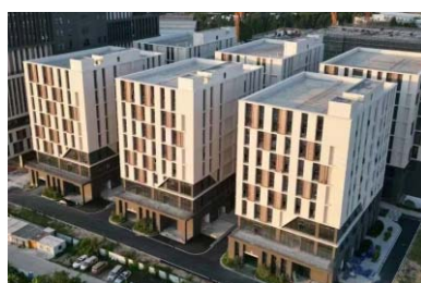
园区一期实景图
