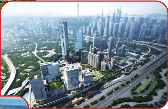
温州二期项目
