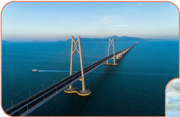
港珠澳大桥项目
