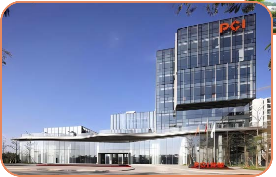
佳都科技长沙地铁合作项目
