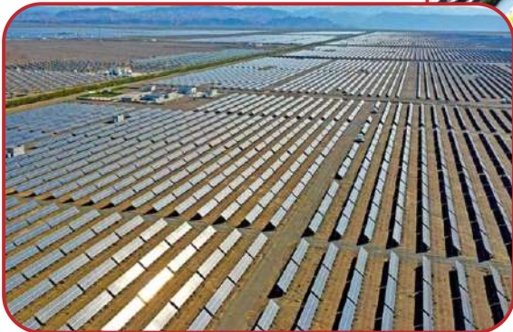
新疆哈戈壁光伏发电项目
