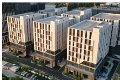
园区一期实景图
