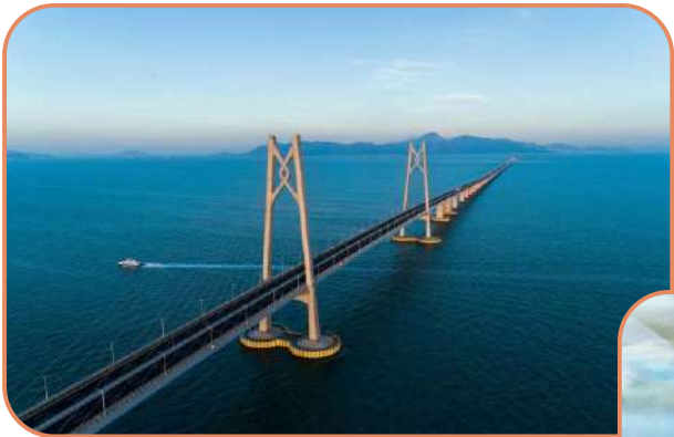
港珠澳大桥项目
