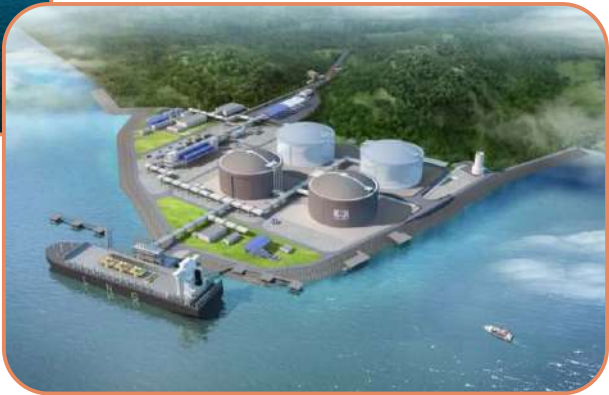
广州LNG应急调峰气源站储气库二期工程项目
