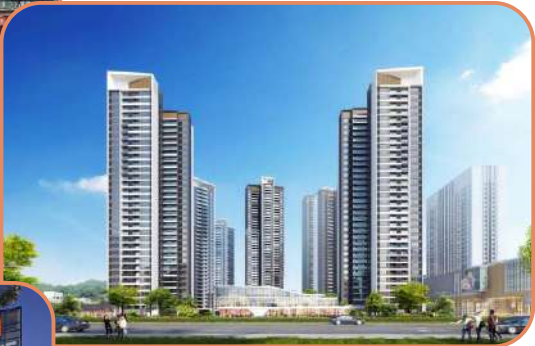
中铁海语熙岸住宅项目
