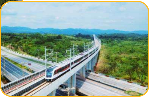
华为成都地铁19号线合作项目
