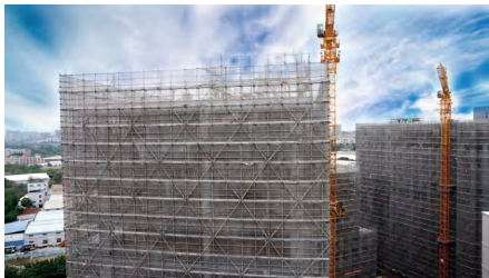
园区二期建设实景图
