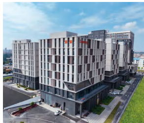
园区一期实景图
